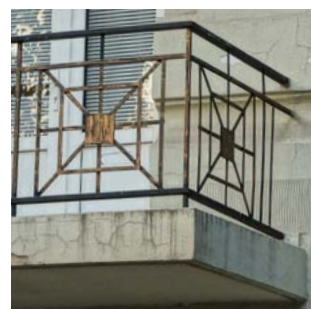
Opravy čel balkonů
