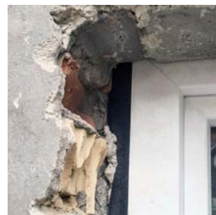
Opravy ostění a špalet
