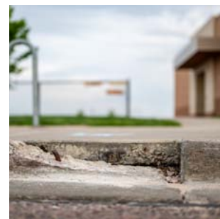
Opravy betonových chodníků
