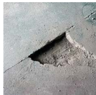
Opravy betonových podlah
