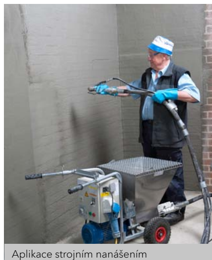
Aplikace přísady VANDEX AM 10 v cementárně
