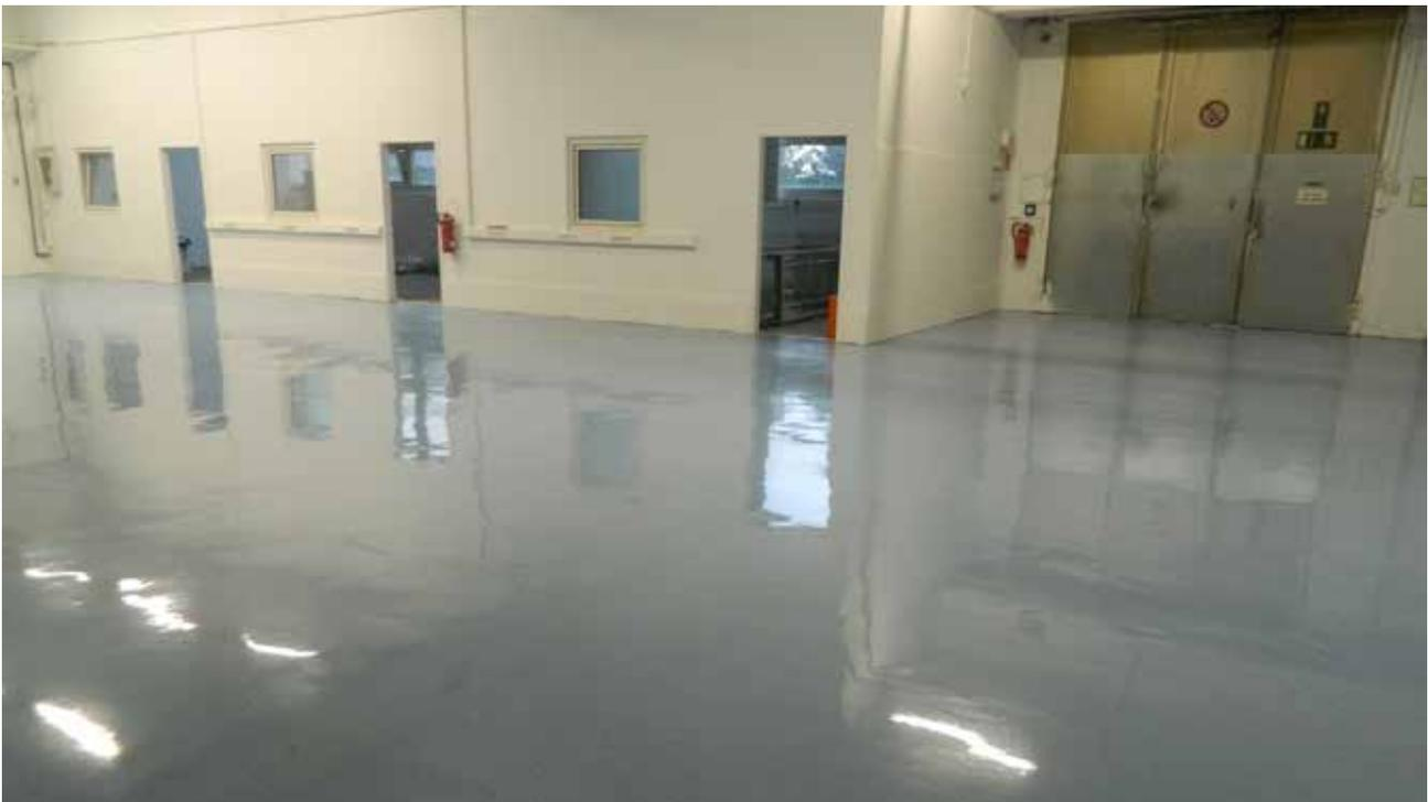
► Der Fußboden einer Druckerei in Berlin war stark abgenutzt und musste dringend saniert werden. Ziel des Projekts war es, die 3.000 m<sup>2</sup> Bodenfläche möglichst zügig zu erneuern, um die Produktionsunterbrechung so gering wie möglich zu halten.
