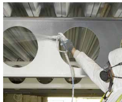
Protección de estructuras metálicas
