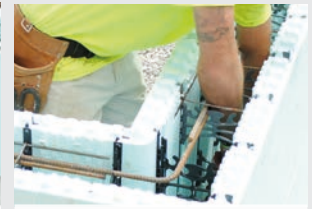
Placera armeringsjärn i väggarna
