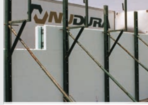
Rikta upp väggen för betong-hållning
