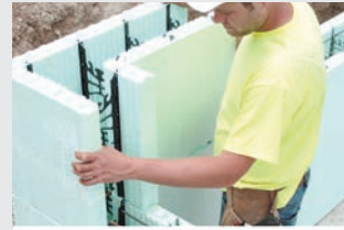
Stapla formar och skapa öppningar
