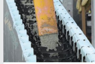
Håll betong i väggarna
