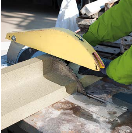
Abb. 1: Schneiden Sie die Zargen zu.
