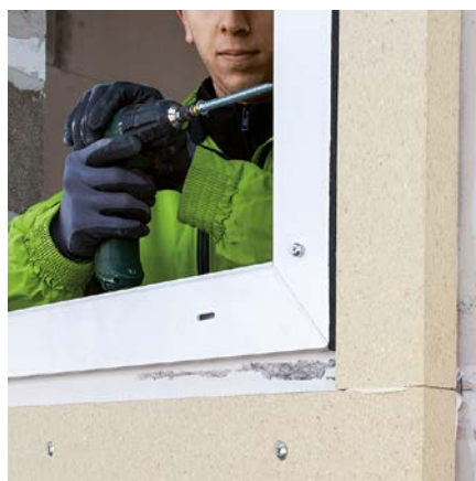
Abb. 8: Befestigen Sie das Fenster mit handelsüblichen Rahmenschrauben und dichten Sie es mit TP652 illmod trioplex+ ab.
