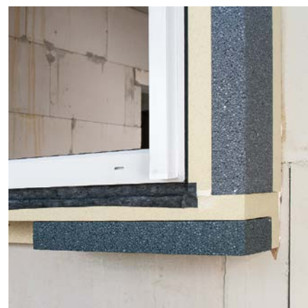
Abb. 9: Verkleben Sie unter der Außenfensterbank eine ME503 TwinAktiv VZ Folie gegen drückendes Wasser. Bei Bedarf können die Zargen mit dem passenden PR008 Dämmkeil ergänzt werden.
