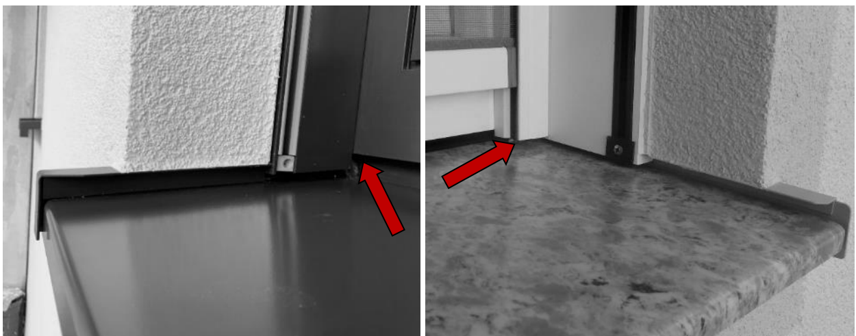
Abbildung 18: Gewerkeloch im Bereich der Führungsschiene; Sofern die Fensterbank vor der Führungsschiene montiert wird, hat der Verschluss des Gewerkeloches in der Regel durch den Führungsschienenmonteur zu erfolgen. Bei Montage der Fensterbank nach dem Einbau der Führungsschienen, hat der Verschluss in der Regel durch den Fensterbankmonteur zu erfolgen.
