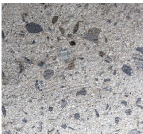
Gestrahler, angerauter Beton mit offener Textur und freiliegenden Zuschlagstoffen
