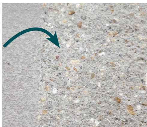
Gestrahler, angerauter Beton mit offener Textur und freiliegenden Zuschlagstoffen
