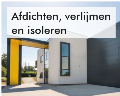
Kozijn- en raammontage, gevelconstructie, gevelisolatie- en afwerkingssystemen (EIFS)
