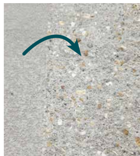
Betong, der er blevet slyngrenset, fræset eller slebet til en åben tekstur med synligt aggregat i overfladen
