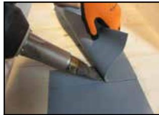
Bandoberflächen mit Heissluft wärmen und zusammenpressen
