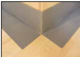
Das Band bis zur Mitte einschneiden und an der Aussenecke einpassen
