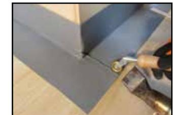
Für einwandfrei dichte Bandverbindung Schweissränder wärmen und mit Roller nachpressen
