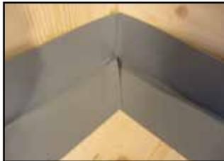
Das Band bis zur Mitte einschneiden, an der Innenecke einpassen; Überlappung: > 2 cm, Rest wegschneiden
