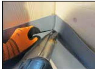
Bandoberflächen mit Heissluft wärmen und zusammenpressen; Arbeitsrichtung: von der Ecke nach aussen
