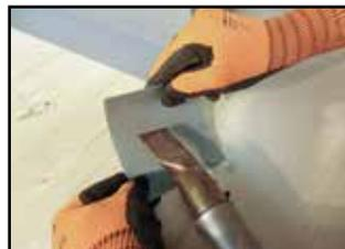
Ergänzungs-Bandstück zuschneiden; eine Ecke mit Heissluft wärmen, etwas auseinander ziehen und ...
