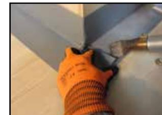
Bandoberflächen mit Heissluft wärmen und zusammenpressen; Arbeitsrichtung: von der Ecke nach aussen
