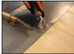
Für einwandfrei dichte Bandverbindung Schweissränder wärmen und mit Roller nachpressen
