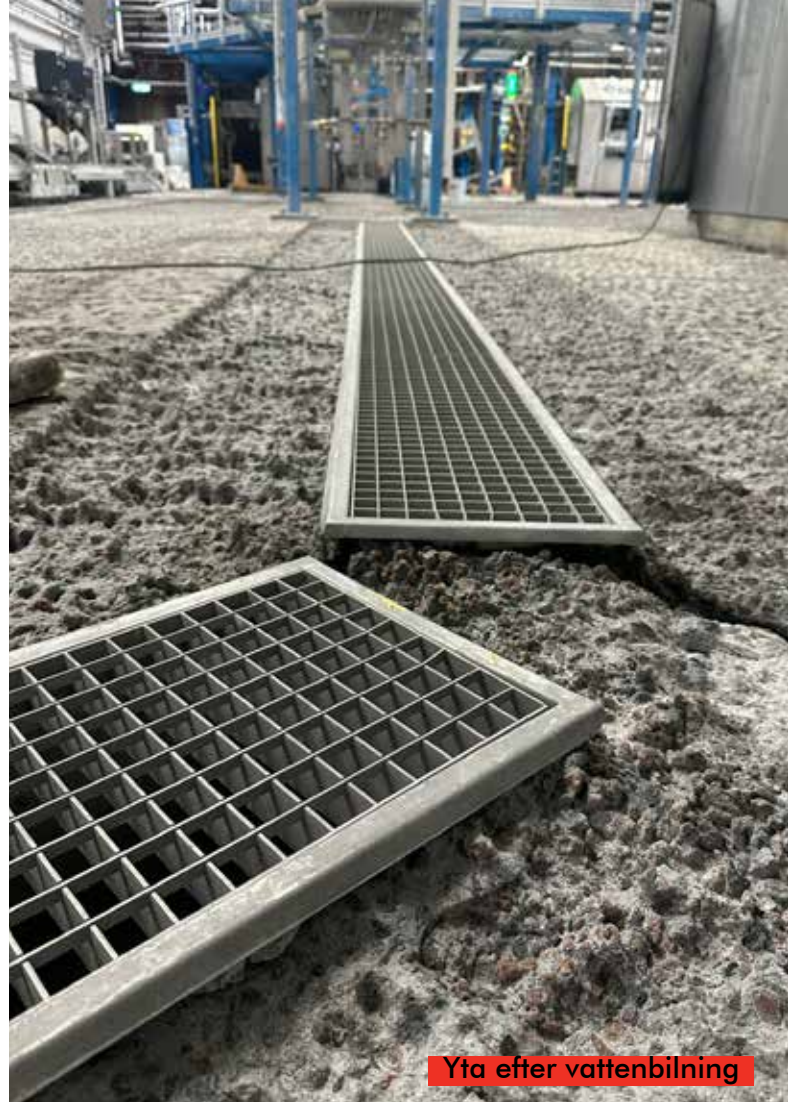
Yta efter vattenbilning
