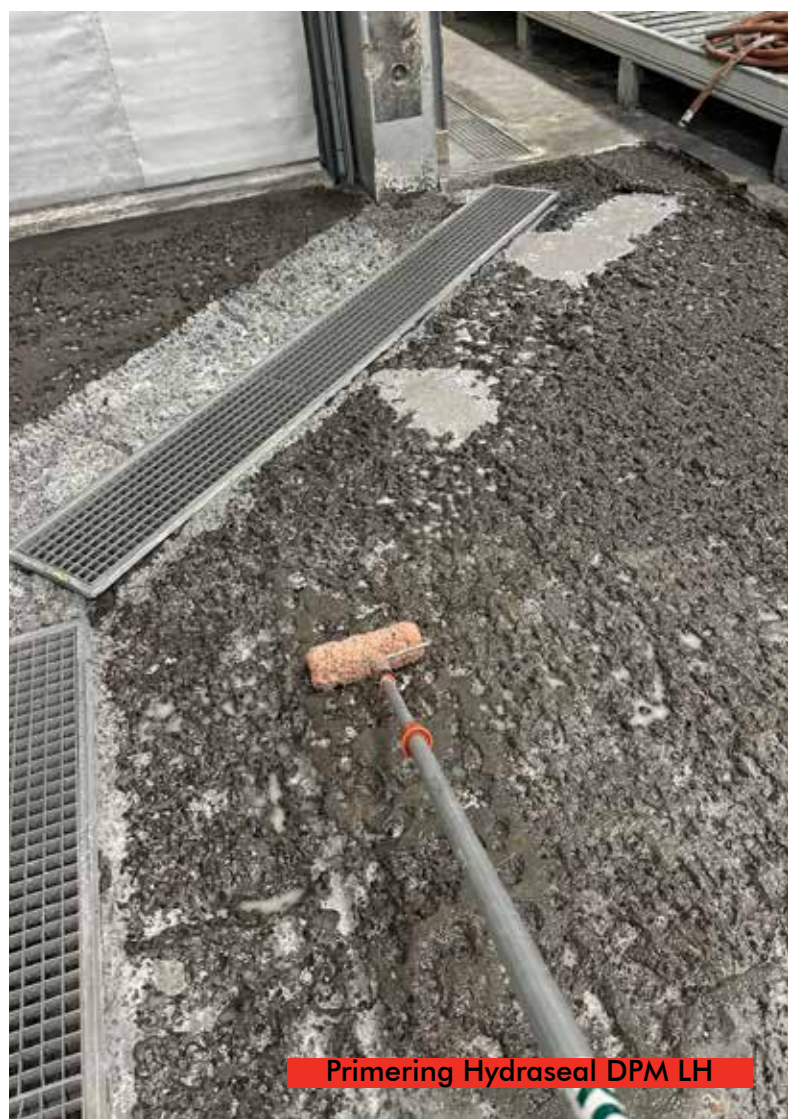
Yta efter vattenbilning
