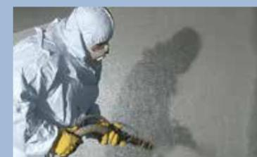
Spritzapplikation der Deckschicht
