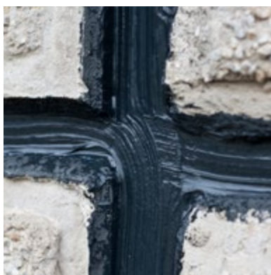
Precízny a čistý detail po vytvrdnutí.
