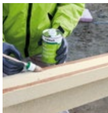
3. Príprava lepených plôch podkladovým náterom illbruck AT140.
