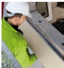
6. Inštalácia L profilu PR010 na murivo.
