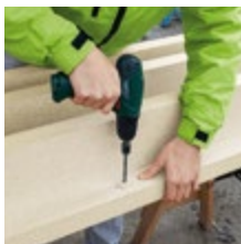
2. Predvrtanie otvorov pre poistné šróby.
