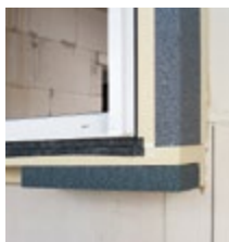
9. Aplikácia hydroizolačnej fólie illbruck proti tlakovej vode a izolačných klínov PR012.
