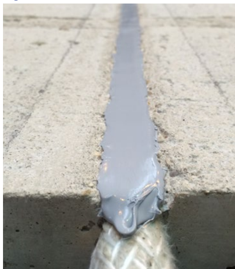
FJ203 povezan s FO142/3 Intutac + FS703 Intusil radi vodonepropusnosti: EI240
