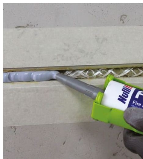
Rostul poate fi sigilat ulterior, după preferință, cu un material de etanșare adecvat (de ex. Nullifire FS702, FS703 sau illbruck SP525)
