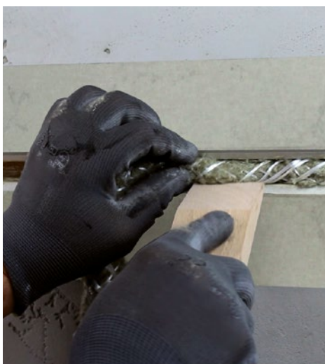
Introducerea șnurului Nullifire FJ203 în rost
