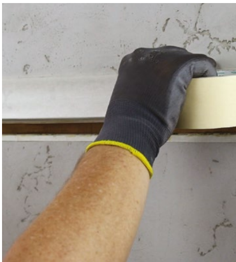
Aplicarea unei benzi adezive protectoare pe marginile rostului
