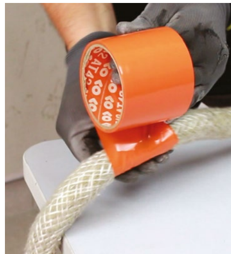
Aplicarea unei benzi adezive pe Nullifire FJ203, pentru facilitarea tăierii
