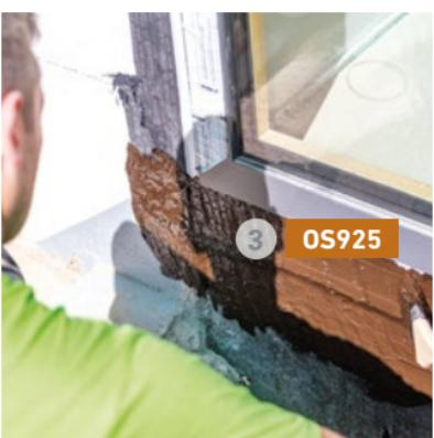
Izravno premažite spojnu prirubnicu i donji priključak s OS925 premazom za brtvljenje.
