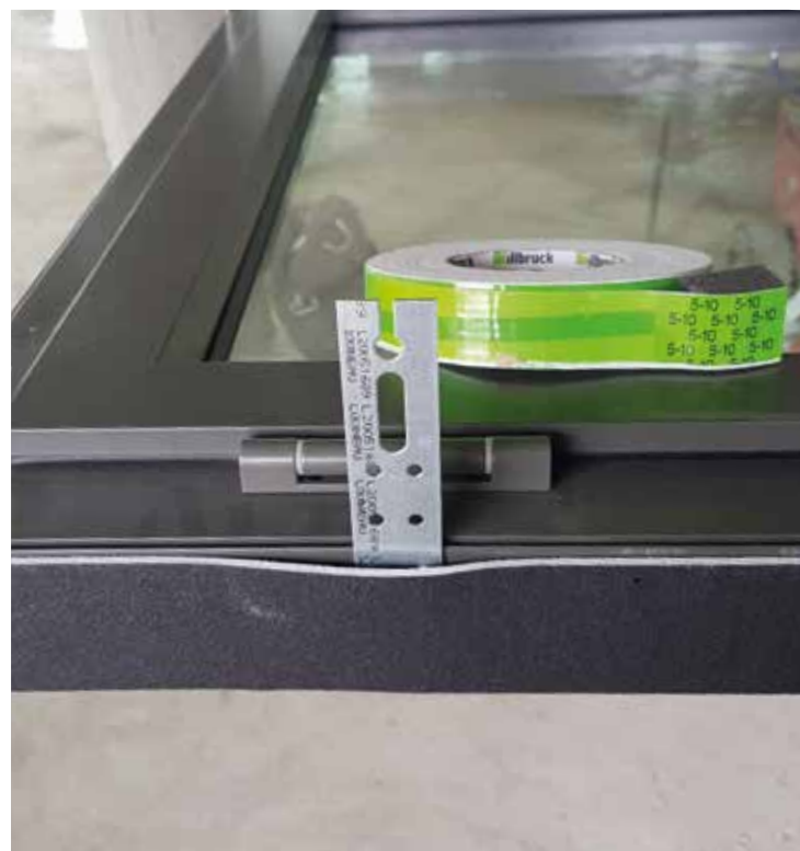
Sistema i3 con un solo producto: TP650, la cinta de espuma impregnada multifuncional.
