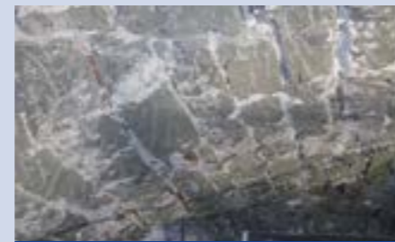
3. Beschadigd pleisterwerk verwijderd
