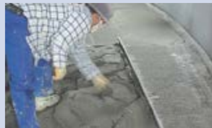
Plaatsen van dekvloer
