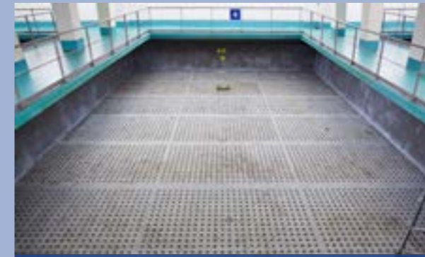
Voor de renovatie
