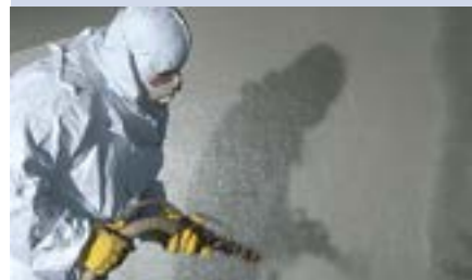
Aanbrengen van sanitaire coating
